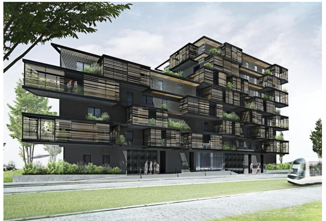
Le nouveau bâtiment intègre deux opérations : à gauche le Beaupré, à droite le Safran. DOCUMENT REMIS
